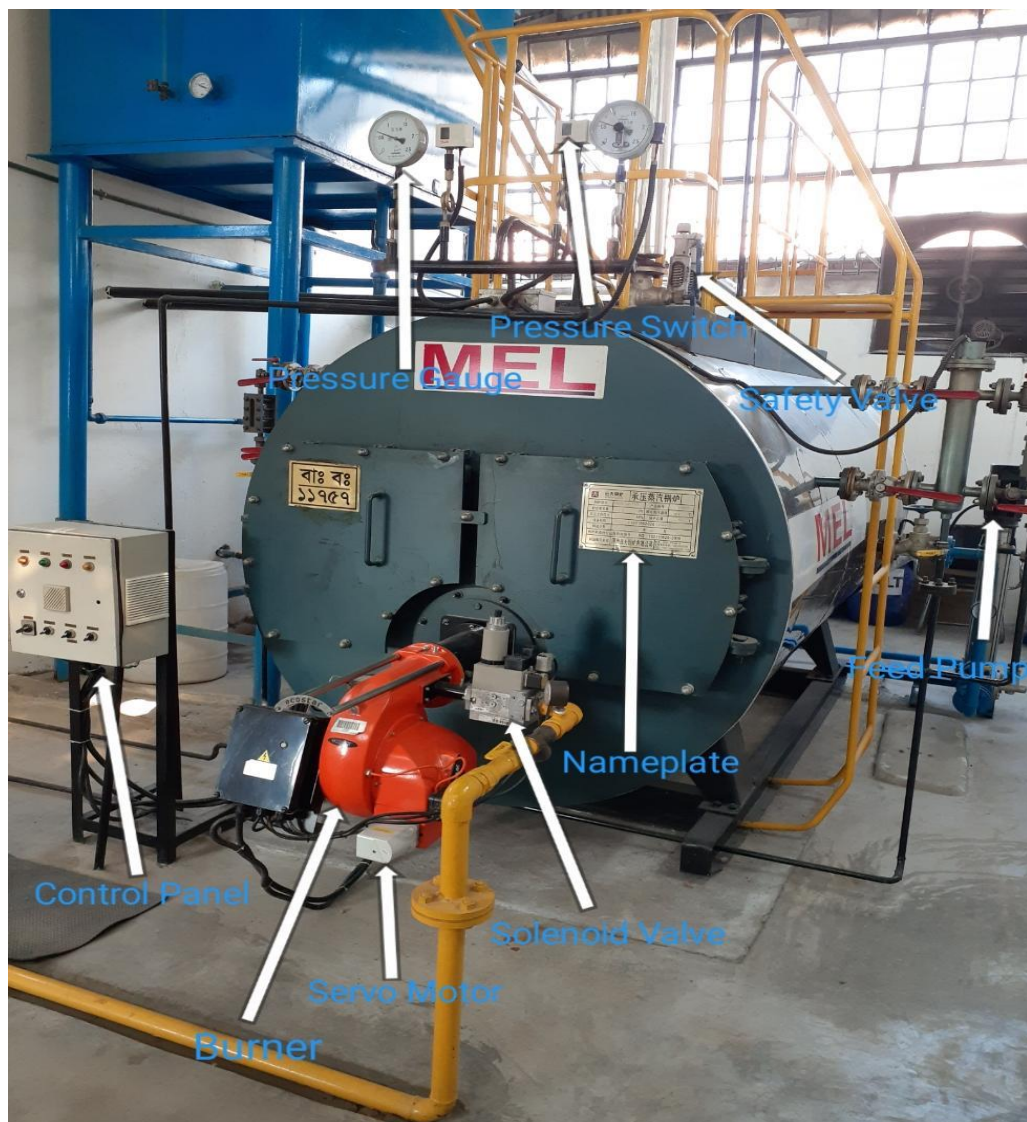
Fig: 8.1 Boiler.
