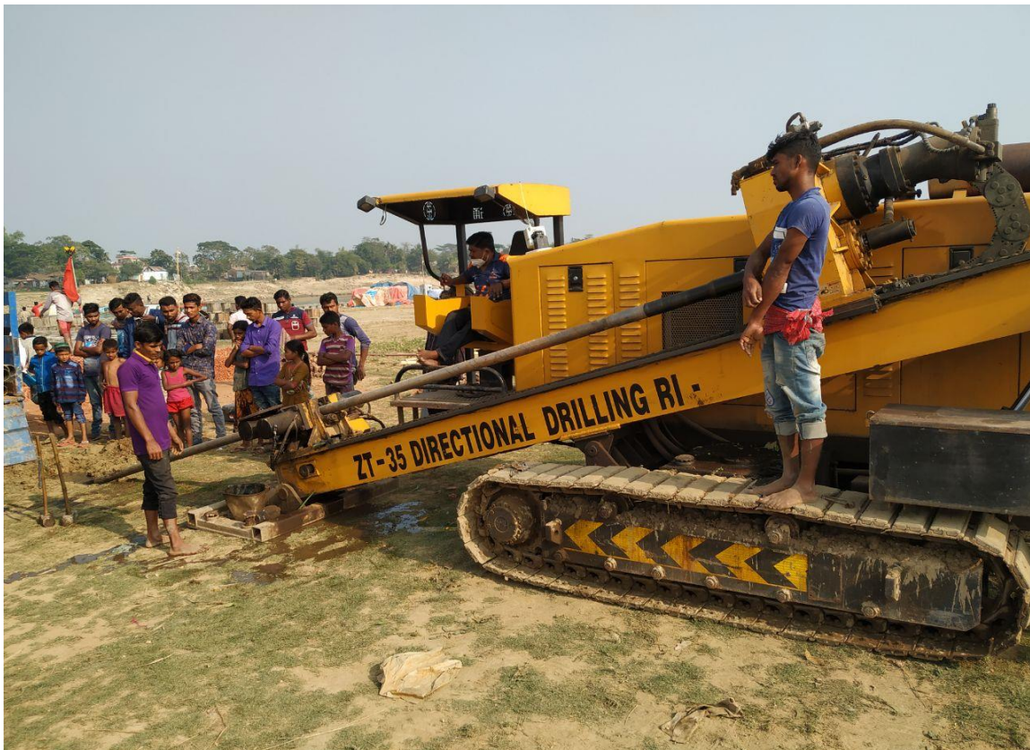
Image 3.1 : SComm HDD work
