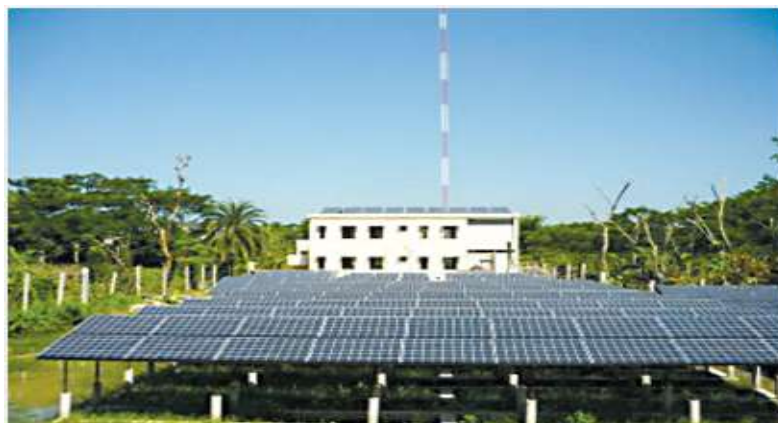
Figure 2.21: Solar Mini grid System
