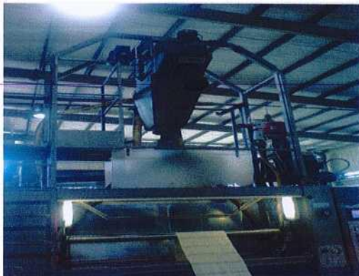
Fig: De-water M/c
