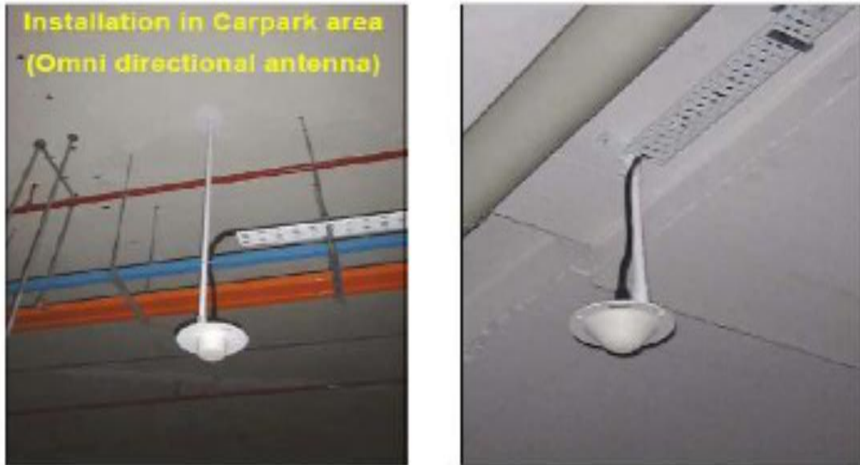
Fig.7.1: Omni Antennas
