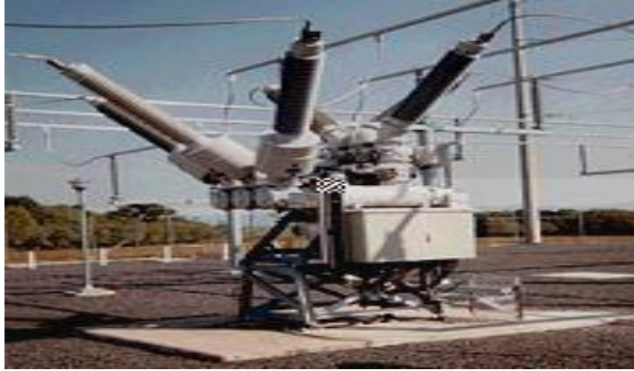
Fig3.3: Hybrid switchgear
