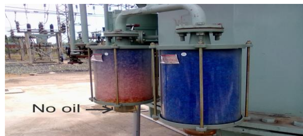
Fig: Silica Gel Breather
