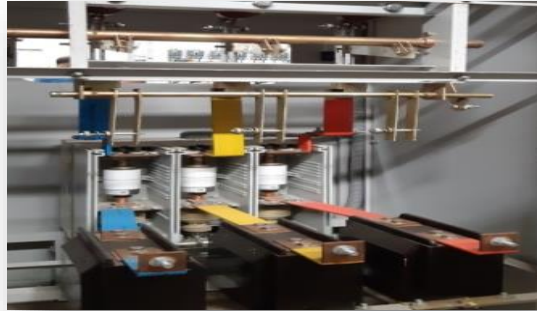
Fig 7.3: HT Switchgear
