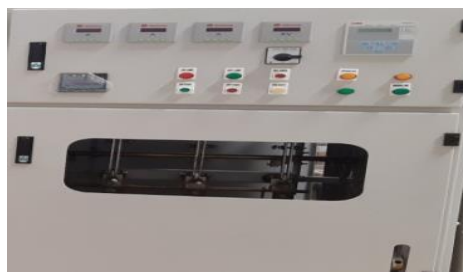
Fig 7.4: LT Switchgear
