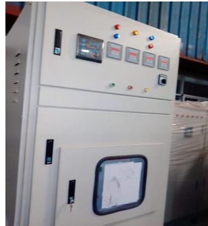
Fig: HT Switchgear
