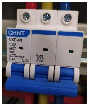
Figure: 4(a) MCB(Schneider & ChiNT)
