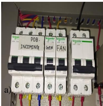
Figure: 4(a) MCB(Schneider & ChiNT)
